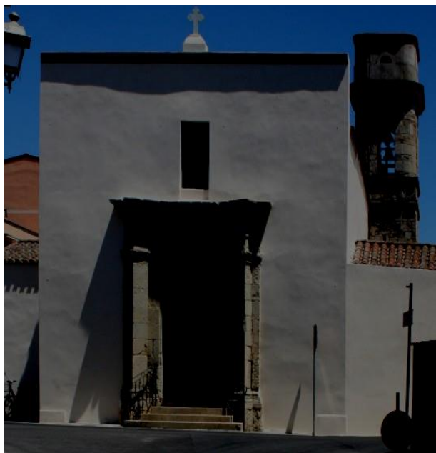
Figura 1. Fronte principale della chiesa della B.V della neve
