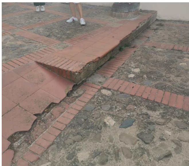
Figura 6- attuale dislivello tra zona sagrato e piazza retrostante
