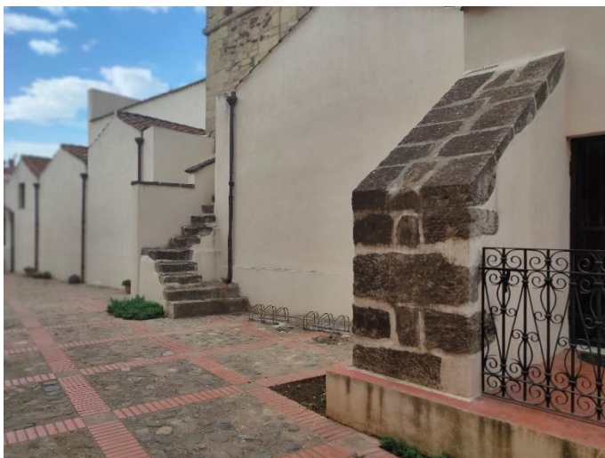
Figura 4. Particolare dei conci basaltici utilizzati nella costruzione
