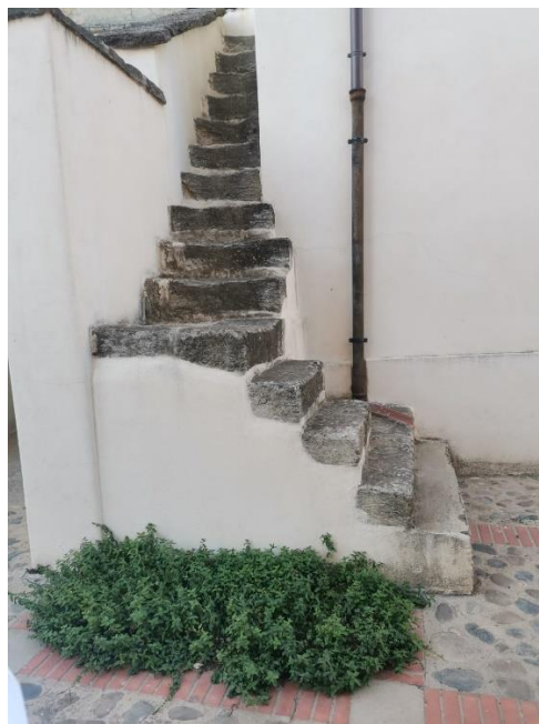
Figura 2. Accesso al campanile
